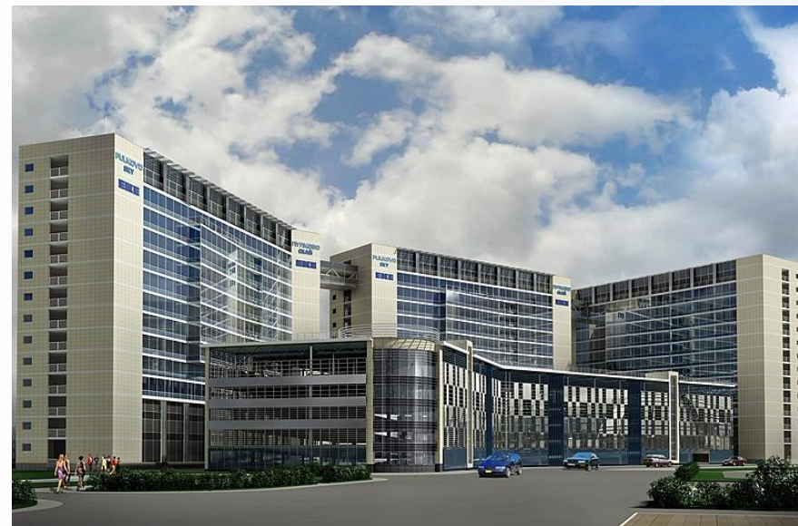
Бизнес Центр «Пулково Скай», г.Санкт-Петербург
