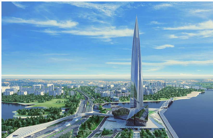
Общественно-деловой комплекс «Лахта-Центр», г.Санкт-Петербург
